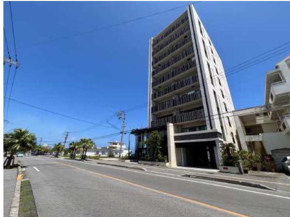
前面道路 国道390（北西側から撮影）
