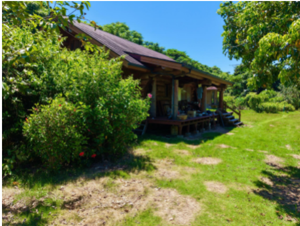
建物（北側から撮影）
